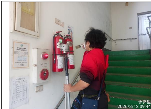
圖 17. 檢查立新實習工廠滅火器
