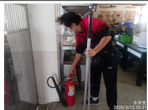
圖 16. 檢查立規樓滅火器
