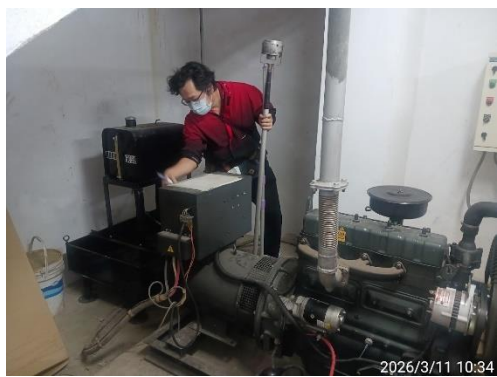
圖 13. 檢查立信樓發電機
