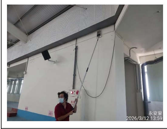
圖 27. 檢查活動中心紅外線偵測器
