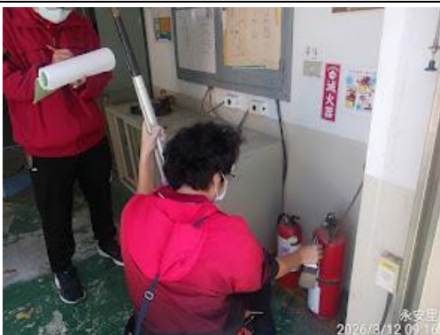
圖 15. 檢查立規樓滅火器
