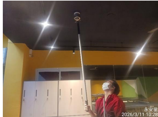
圖 10. 檢查立信樓偵測器
