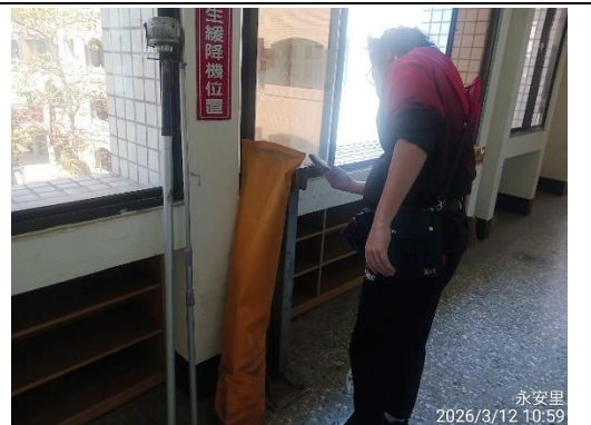
圖 20. 檢查立業樓逃生緩降機
