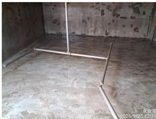
圖 61. 立信樓頂水泥水塔清洗前
