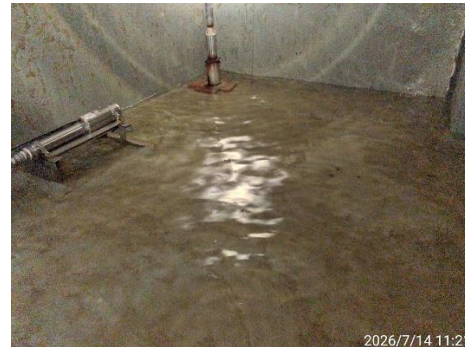
圖 52. 立信樓地下室水泥水塔清洗前
