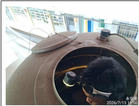
圖 17. 立志樓#3 清洗中
