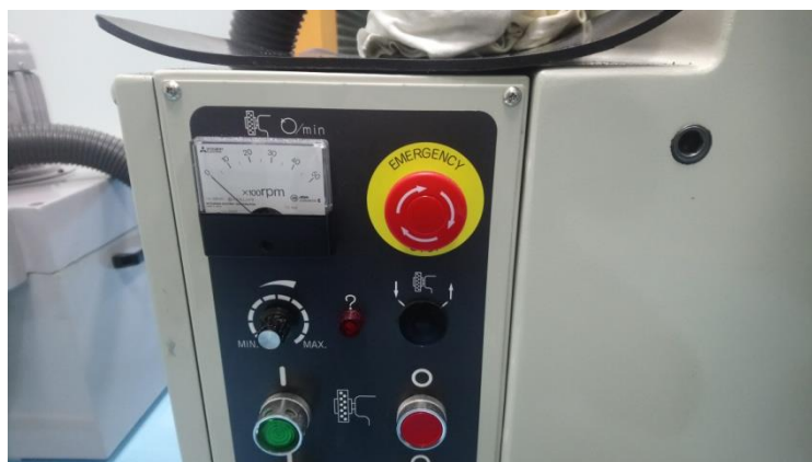
動力遮斷裝置
