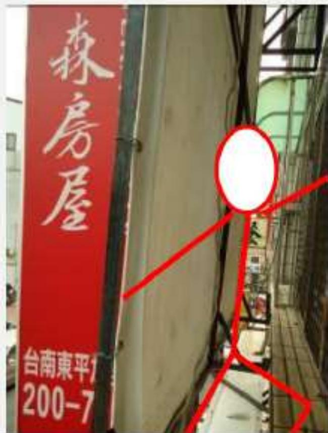
帆布廣告支撐架與牆壁間實施帆布廣告更換作業，因安定器絕緣被破壞致引起感電災害
