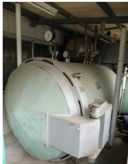
局部排氣管路脫離及未每年依規定定期實施檢查一次
