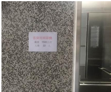
升降機各樓出入口及搬器內，應明顯標示其積載荷重或乘載之最高人數，並規定使用時不得超過限制。
